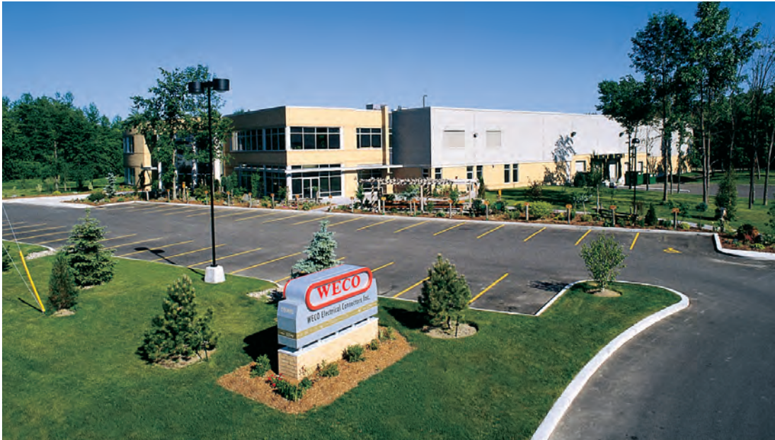
WECO Electrical Connectors in Baie d'Urfé 2008
